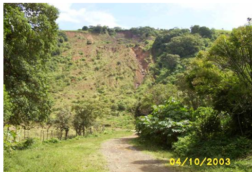
Fotografía 6 Deslizamiento principal flanco occidental del Cerro Tapezco
